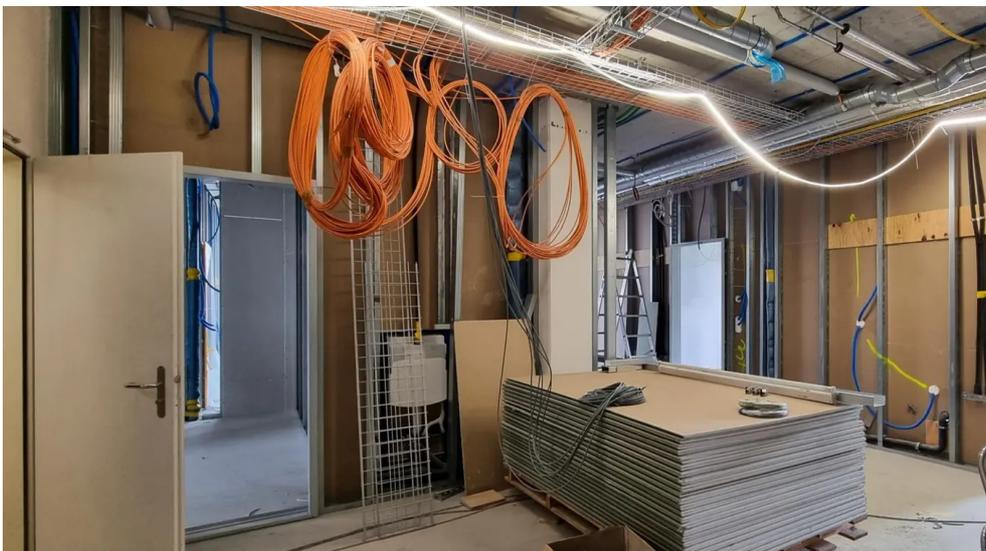
Kilometerlange Leitungen werden verlegt und neue Zwischenwände gestellt.
